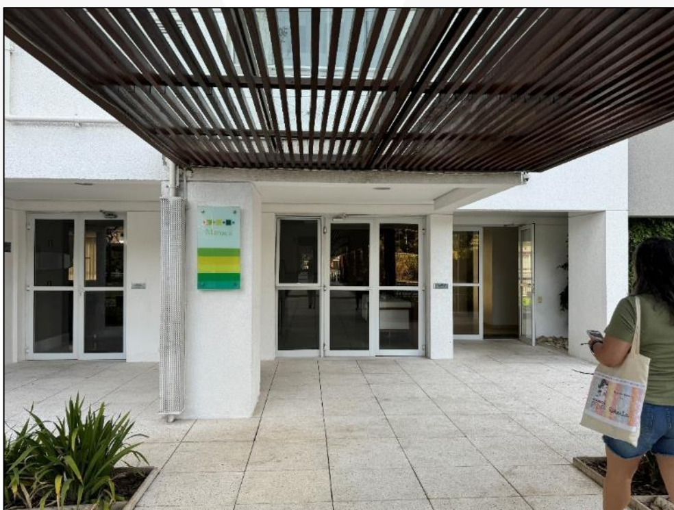
Foto 32 – Acesso ao edifício.
