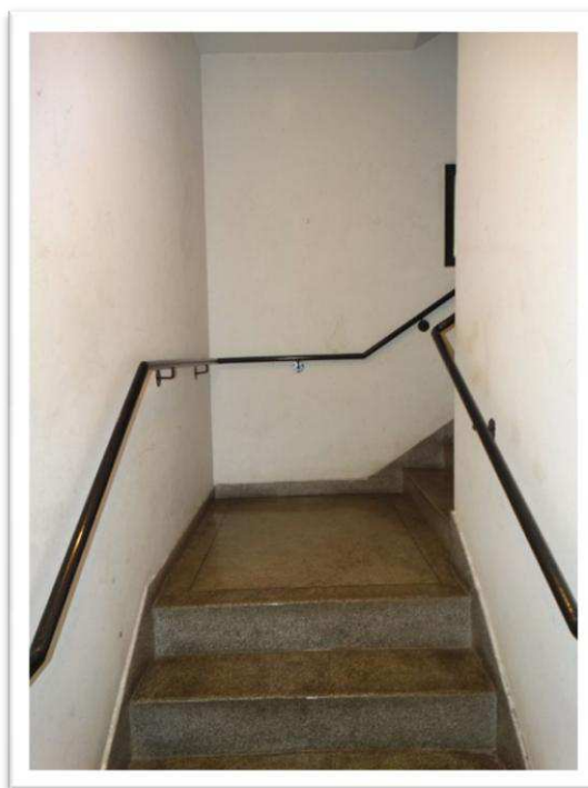
Foto nº 15 - Vista da Caixa de Escada no pavimento térreo do Bloco “B”.
