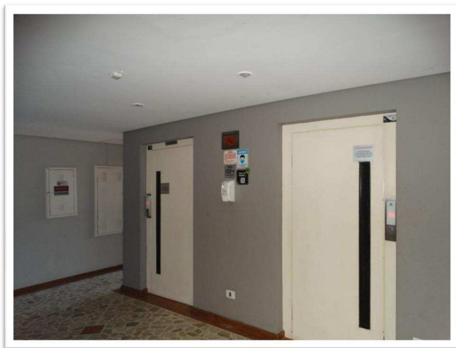
Foto nº 13 - Vista do Hall dos Elevadores, no pavimento térreo do Bloco “B”, onde situa-se o apartamento nº 82, objeto da lide.
