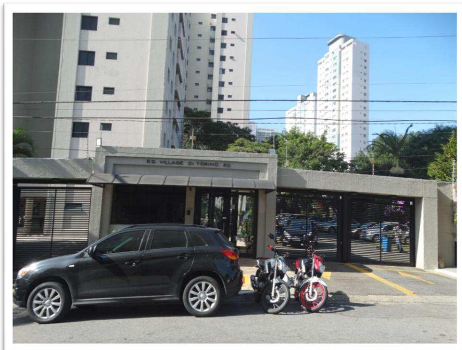
Foto nº 1 - Vista frontal do CONJUNTO RESIDENCIAL VILLAGE DI TORINO, situado na Rua Pedro Victor, nº 20 – Cursino – São Paulo/SP.
