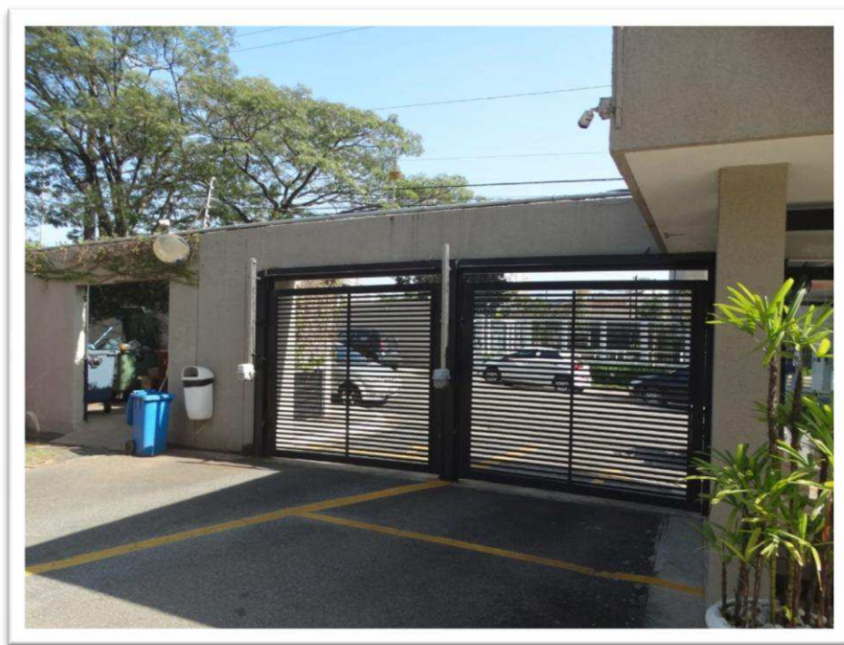
Foto nº 7 - Vista interna do Portão de acesso de veículos ao CONJUNTO RESIDENCIAL VILLAGE DI TORINO.
