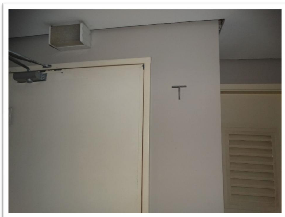
Foto nº 14 - Vista da Placa de identificação do pavimento, no Bloco “B”.
