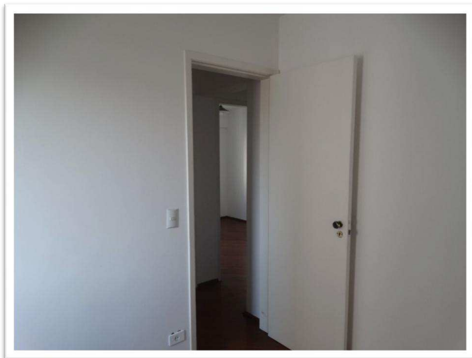
Foto nº 52 - Vista parcial interna do apartamento de nº 92, do Bloco “A”, vistoriado pela similaridade com o imóvel avaliando – Dormitório 3.
