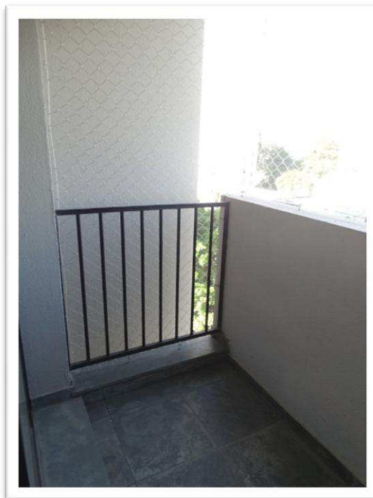
Foto nº 56 - Vista parcial interna do apartamento de nº 92, do Bloco “A”, vistoriado pela similaridade com o imóvel avaliando – Varanda.
