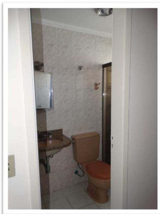
Foto nº 48 - Vista parcial interna do apartamento de nº 92, do Bloco “A”, vistoriado pela similaridade com o imóvel avaliando – Banheiro da Suite.
