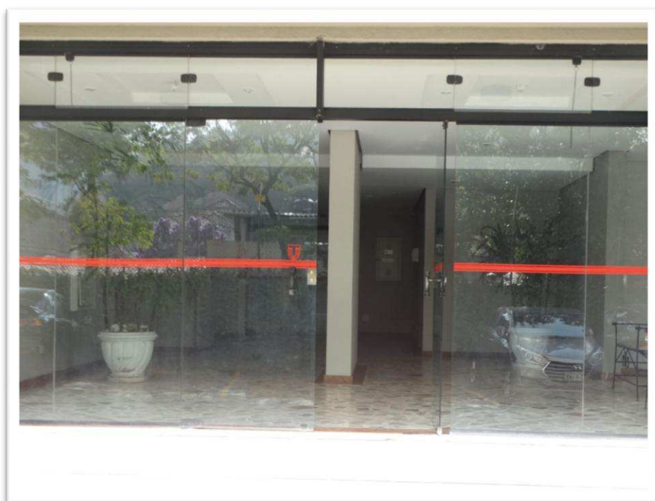
Foto nº 36 - Vista da porta de entrada do Bloco "A", identificado como Bloco "I", onde situa-se o apartamento de nº 92, vistoriado pela similaridade com o imóvel avaliando.
