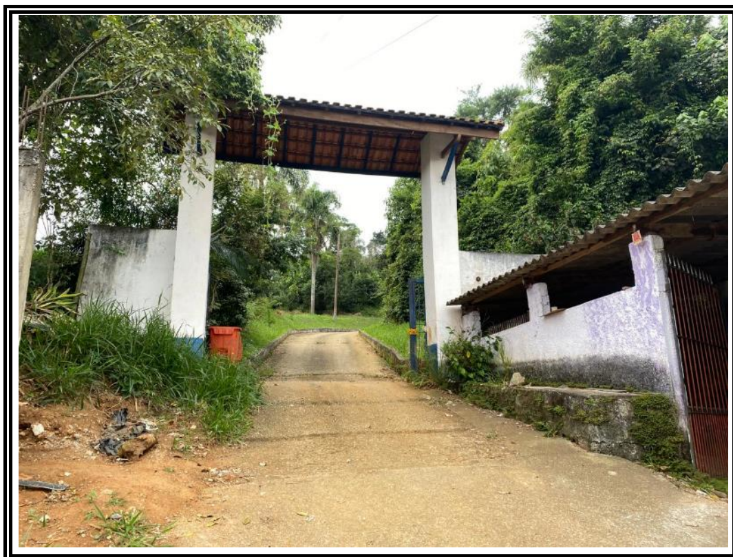
Vista da entrada do imóvel objeto da lide (final da Rua São José)
