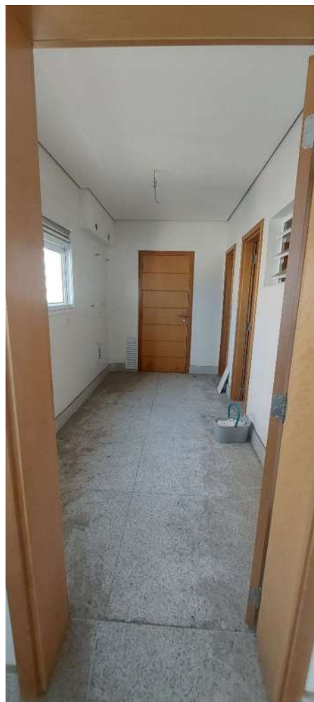
Vista da Área de Serviço
