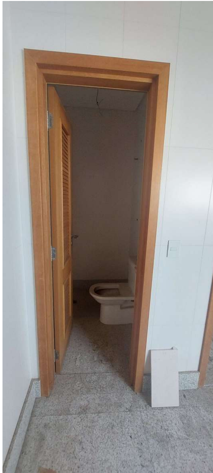
Vista do Banheiro de Empregados
