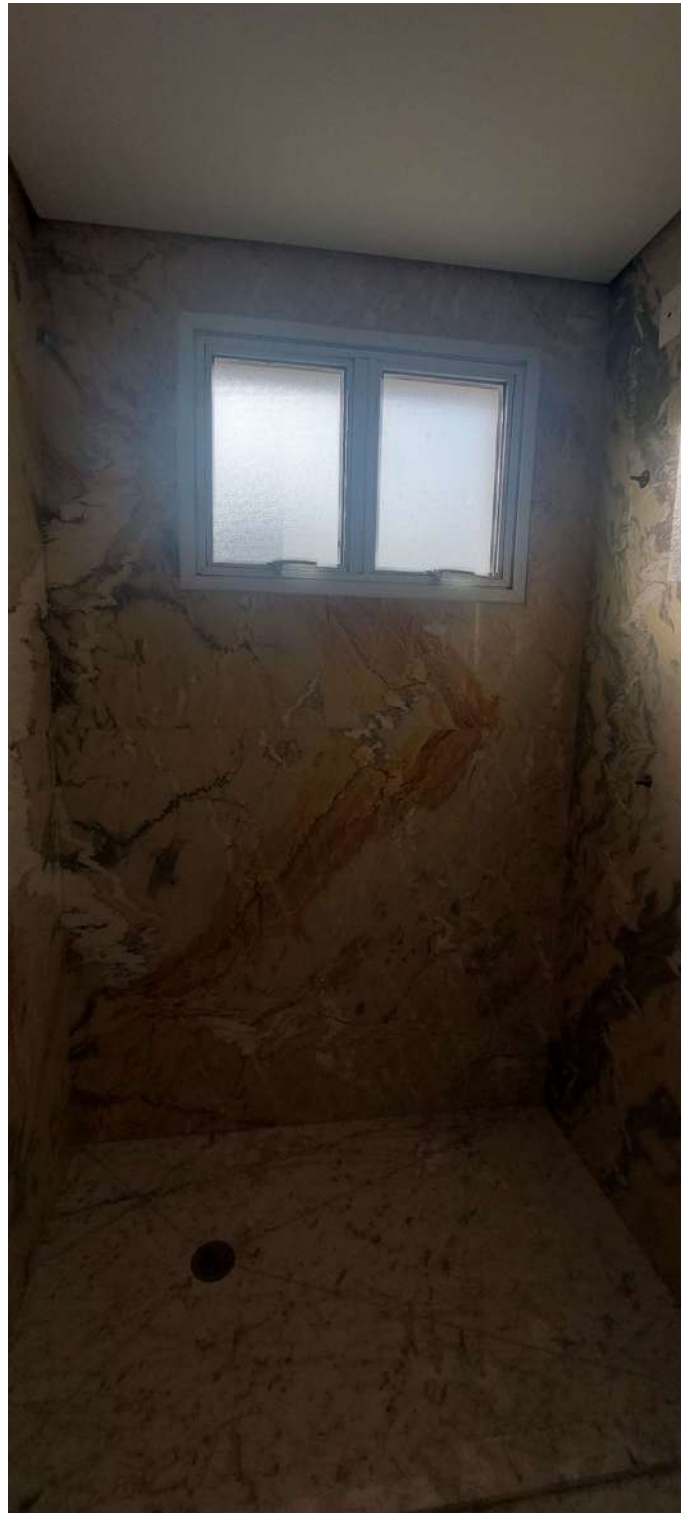
Vista do Banheiro da Suíte 1
