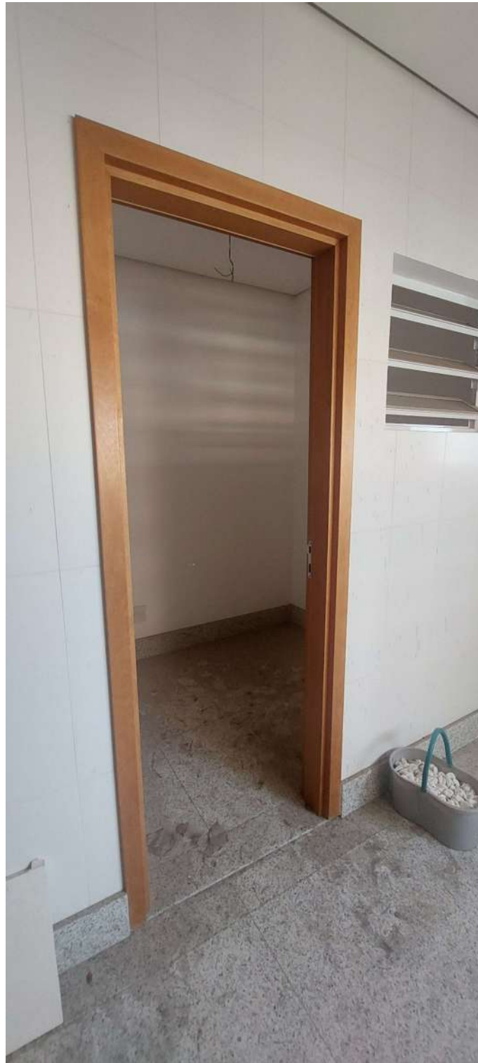
Vista do Quarto de Empregados
