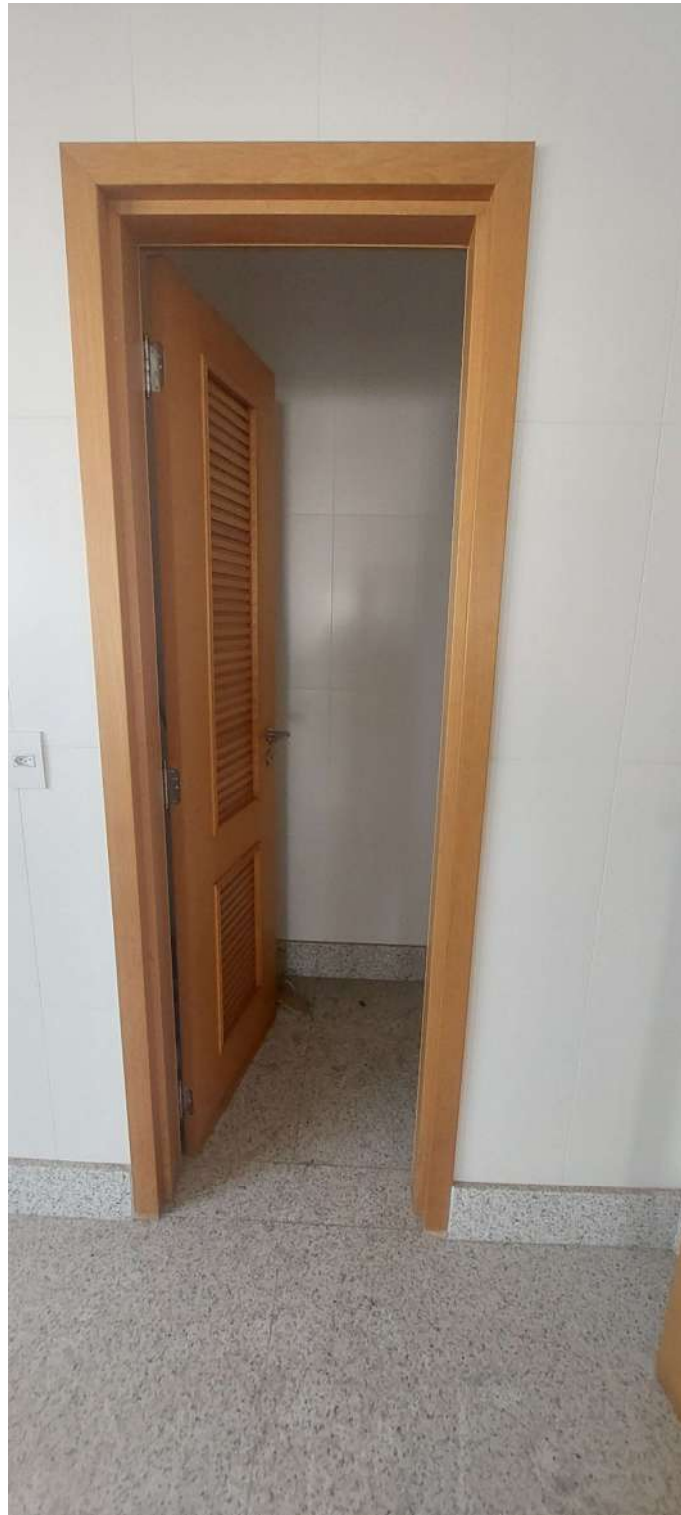
Vista da Despensa
