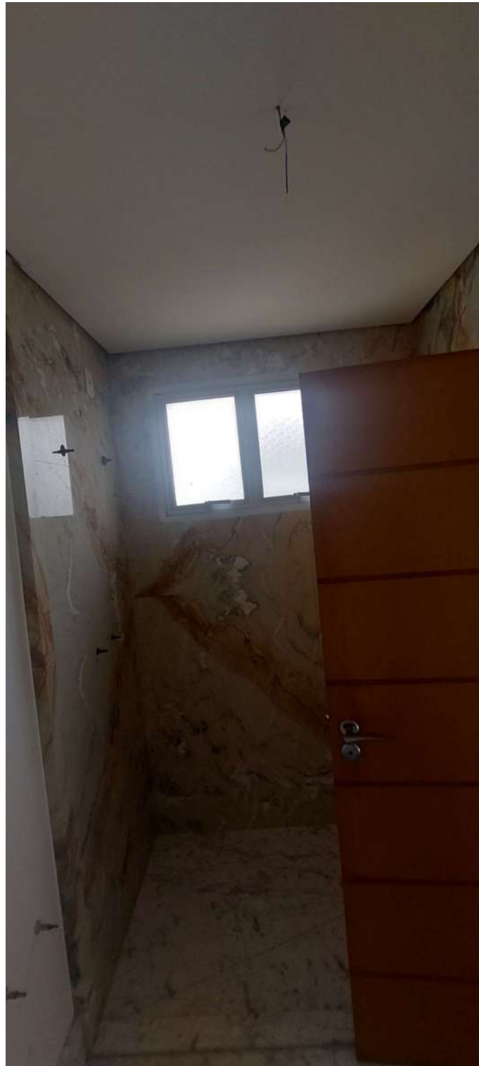
Vista do Banheiro da Suíte 2
