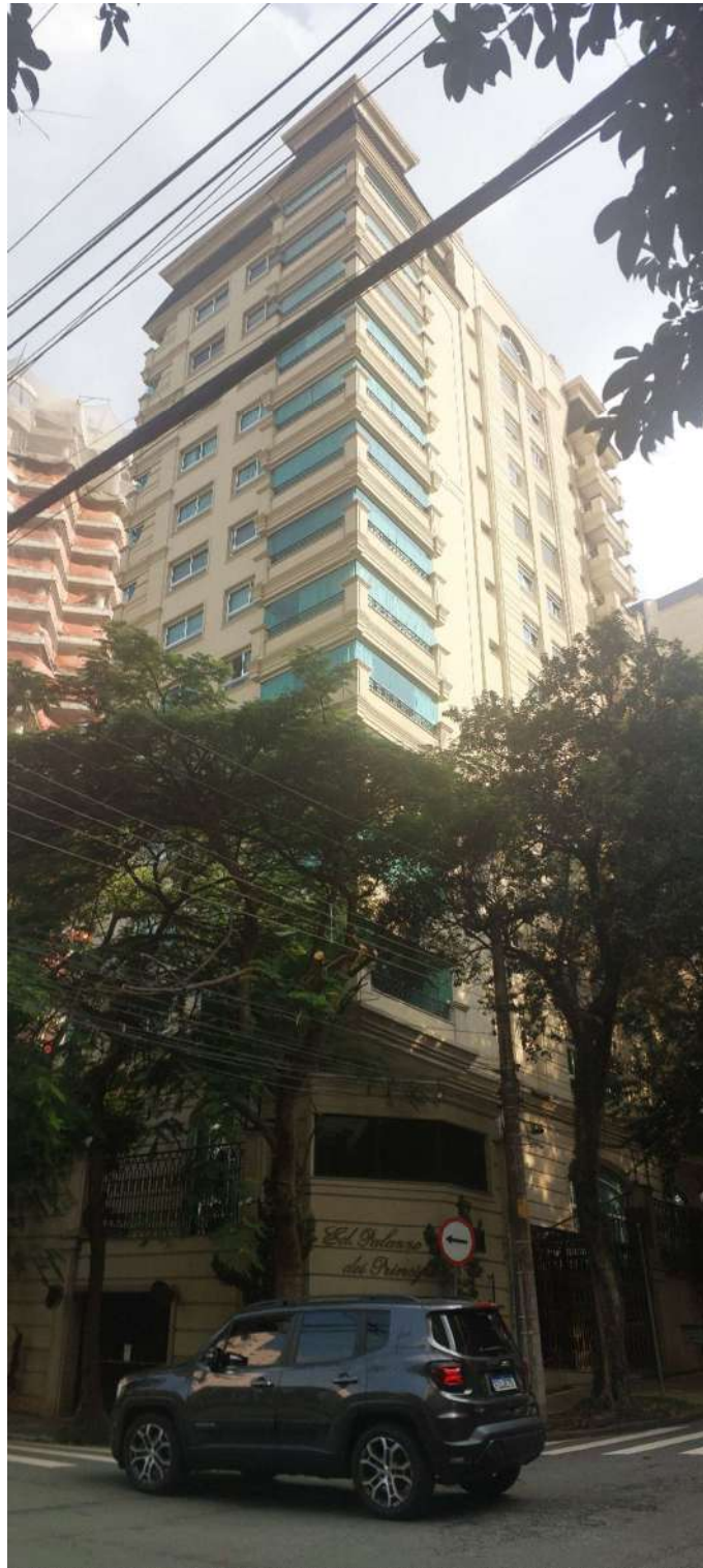
Vista da Torre do Condomínio
