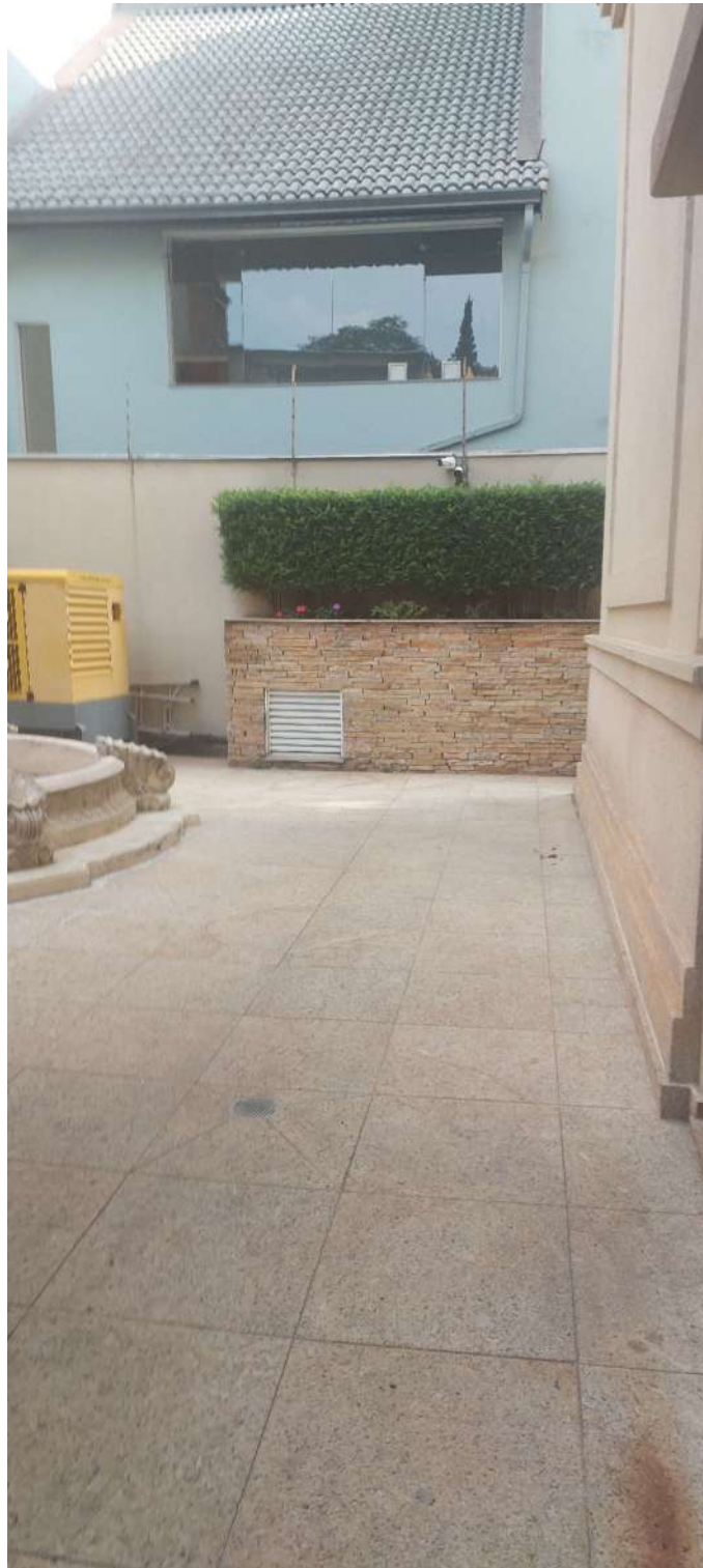
Corredor externo do Condomínio
