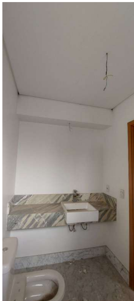
Vista do Banheiro da Suíte 1
