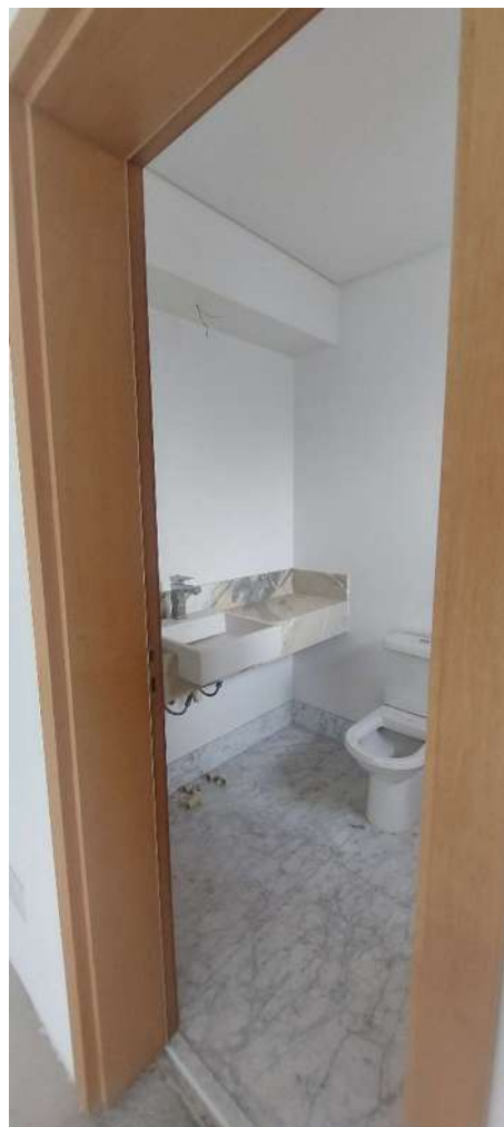
Vista do Banheiro da Suíte 2
