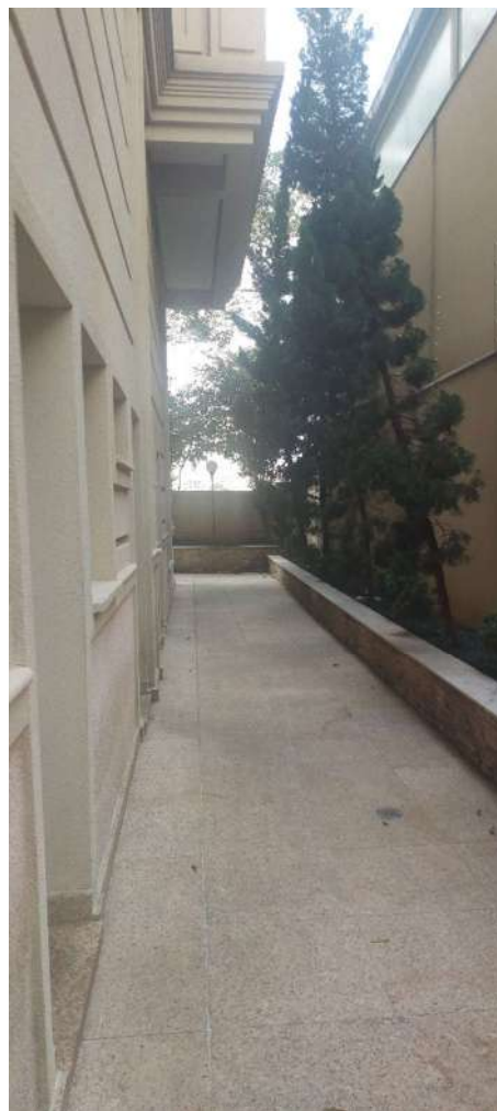
Corredor externo do Condomínio
