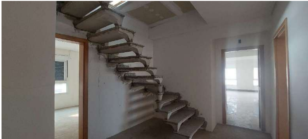
Vista da Escada
