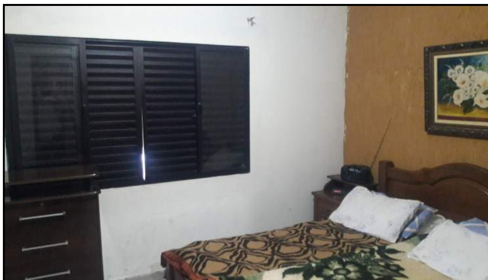
Foto 4 – Dormitório 1 no térreo frente - piso cerâmico, parede com reboco/pintura, esquadria em alumínio
