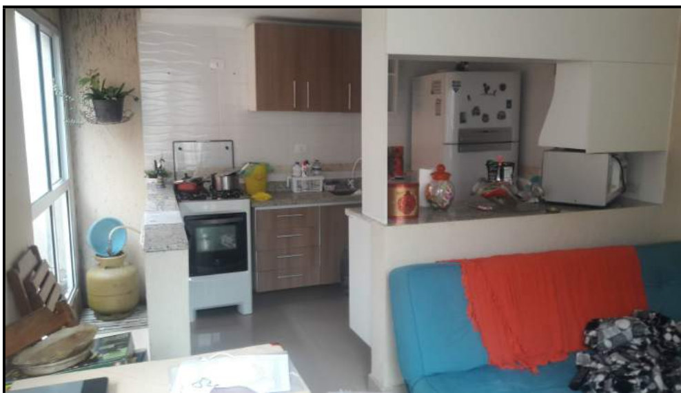
Foto 15 – Sala / Cozinha - piso cerâmico, esquadrias em alumínio, cozinha azulejo sala massa e pintura
