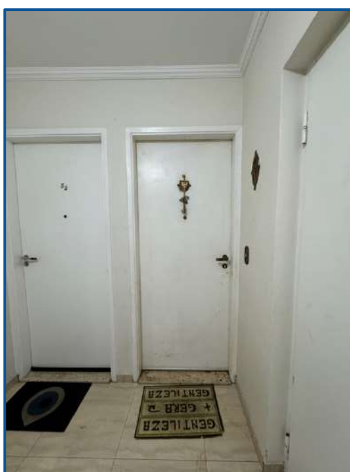
FOTO 20: Porta de entrada do imóvel avaliado
