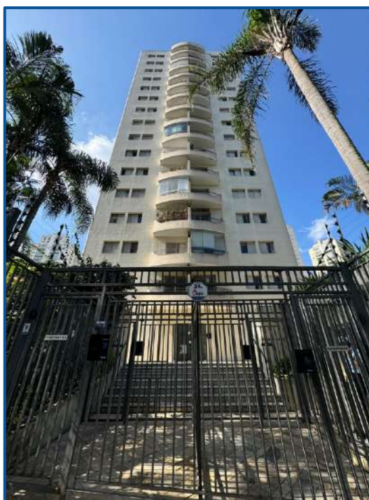
Foto 3: Fachada do condomínio
