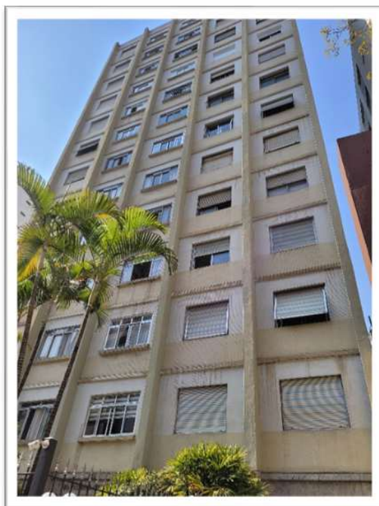
FOTO 02 – FACHADA EXTERNA DO PRÉDIO DO IMÓVEL AVALIANDO
