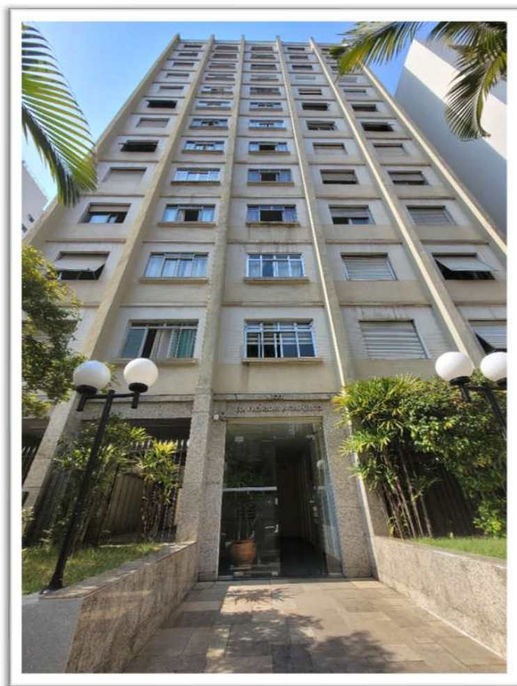
FACHADA DO EDIFÍCIO DO IMÓVEL AVALIANDO
