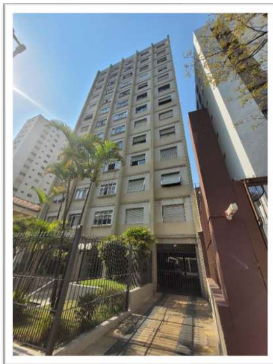
FOTO 01 – FACHADA DO CONDOMÍNIO DO IMÓVEL AVALIANDO
