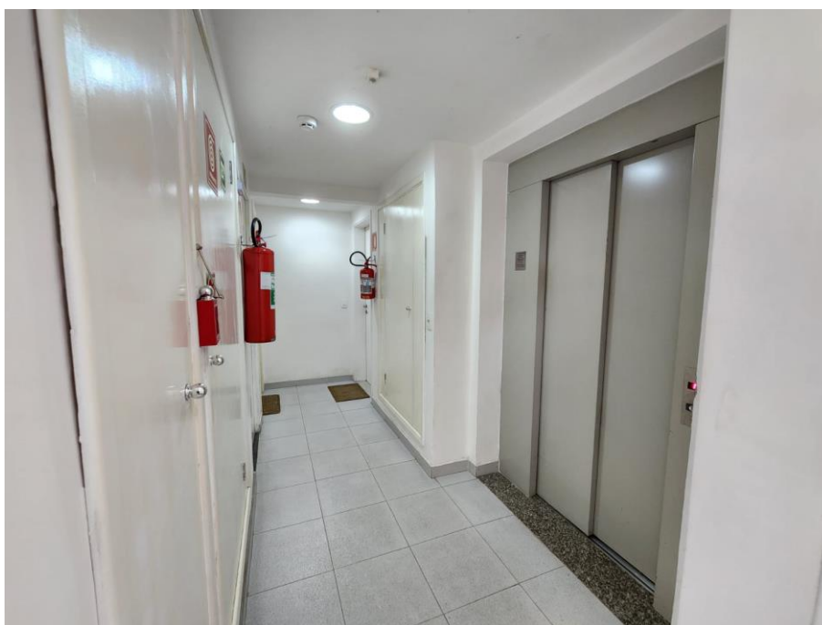
Figura 38 – Hall Serviço – Fonte: Autor
